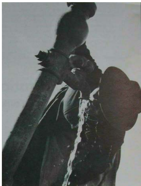
L'eau potable pose partout de nombreux problèmes. Dans ce village des Andes, les habitants se sont cotisés pour amener l'eau jusqu'au village. Avec l'aide d'une ONG, ils ont exécuté eux-mêmes les travaux d'adduction.
