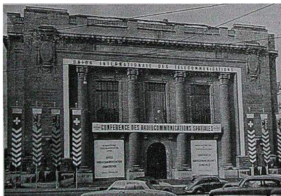
Le « Bâtiment électoral » à Genève, siège de la Conférence des radios communications spatiales de l'UIT. (Photo UIT)
