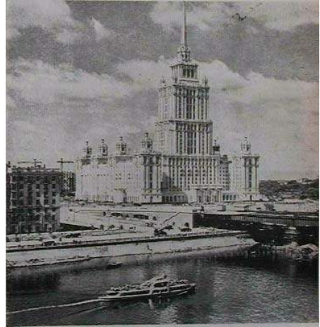
L'hôtel «L'Ukraine» construit en 1957 et comprenant plus de mille chambres dotées de tout le confort moderne.
