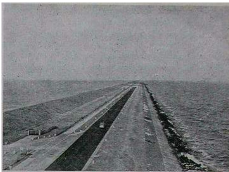
Voyage d'études de la 1 re Section de la CIGR aux Pays-Bas (octobre 1956). La grande digue de fermeture du Zuiderzee (A gauche : la mer du Nord; à droite l'IJsselmeer, ancien Zuiderzee).
