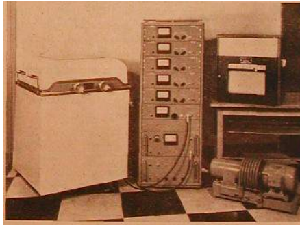
Installation de contrôle de la radioactivité de l'air (mise au point par le Centre d'Etude de l'Energie Nucléaire)
