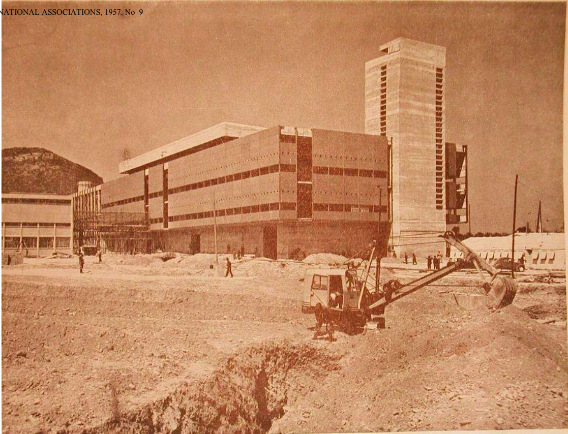
Voici, et, voie d'achèvement, l'usine d'extraction de plutonium de Marcoule, conçue et réalisée par Saint-Gobain, pour le compte du Commissariat à l'Energie Atomique. Cette usine, entièrement télécommandée, sera démarrée au début de 1958.
